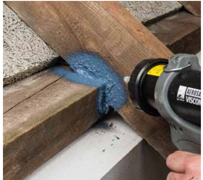
Einfaches luftdichtes Einbinden von Durchdringungen (z. B. Zangen oder Sparren bei der Dachsanierung von außen.)
