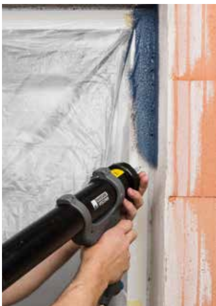
Herstellen der luftdichten Innen- und schlagregendichten Außenanschlüsse im Streich- oder Sprühverfahren. Flexibel einsetzbar auf faserförmigen Dämmstoffen (z. B. Hanf- oder Schafwolle) sowie auf Ortschaum. Anschlüsse innen und außen nach IFT-Richtlinie MO-01/1:2007-01, Abs. 5 geprüft und bestätigt.
