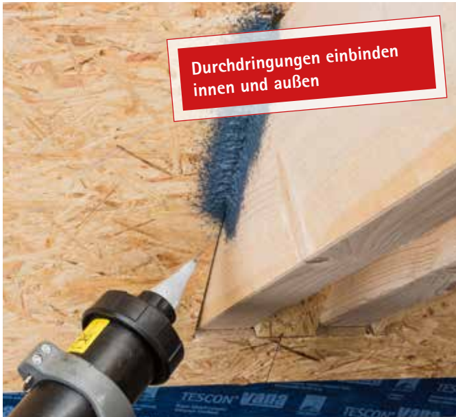
Einfaches luftdichtes Einbinden von Durchdringungen (z. B. Zangen oder Sparren bei der Dachsanierung von außen.)
