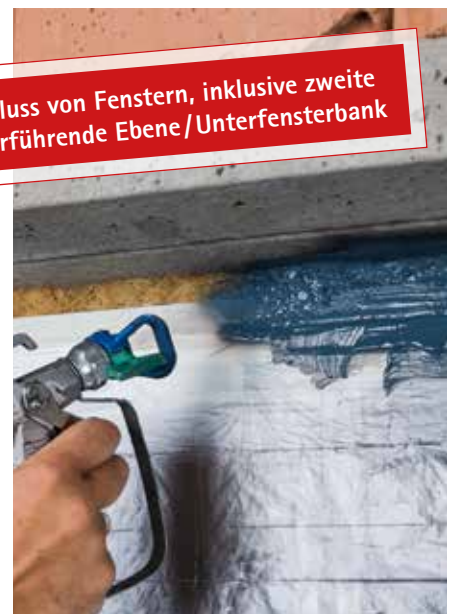
Herstellen der luftdichten Innen- und schlagregendichten Außenanschlüsse im Streich- oder Sprühverfahren. Flexibel einsetzbar auf faserförmigen Dämmstoffen (z. B. Hanf- oder Schafwolle) sowie auf Ortschaum. Anschlüsse innen und außen nach IFT-Richtlinie MO-01/1:2007-01, Abs. 5 geprüft und bestätigt.
